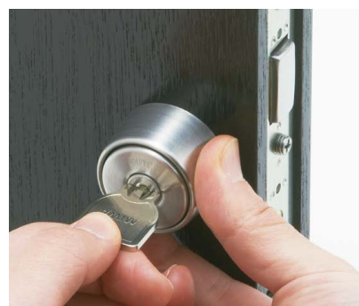
⑥ シリンダーをねじ込むときは一杯まで回し切り、写真のようにMIWAの刻印が上になる位置まで戻してください。この位置が正確でないとシリンダー止めねじが入りません。
